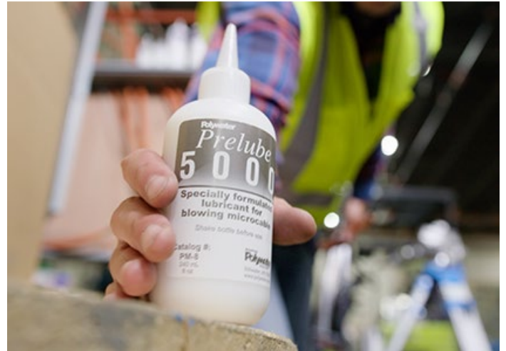
Prelube 5000 wird vor dem Einblasen eines Glasfaserkabels in das Rohr gedrückt
